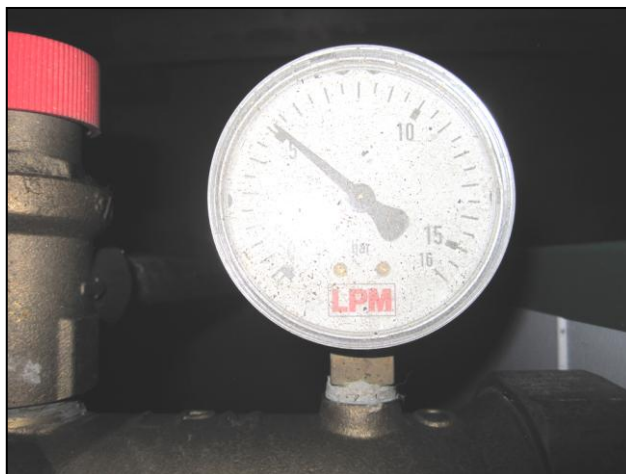
Lämmönsiirtimen vesipainemittari.
