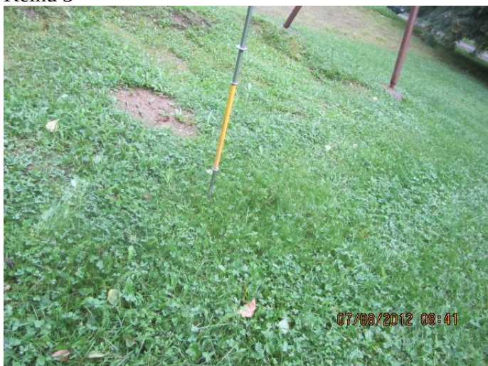
Keinu 3*Turva-alusta ja alue puutteellinen ** Keinun turva-alustan tulee olla 30cm turvasoraa tai vastaava määrä turvamattoa. Turva-alusta alueen koko 4,1 metriä istuimen keskeltä mitattuna molempiin keinumissuuntiin, tolppien leveydeltä. ** Asenna turva-alusta
