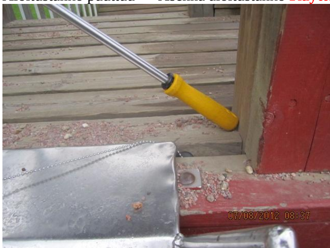
Aloitustanko puuttuu ** Asenna aloitustanko Käyttökiellossa
