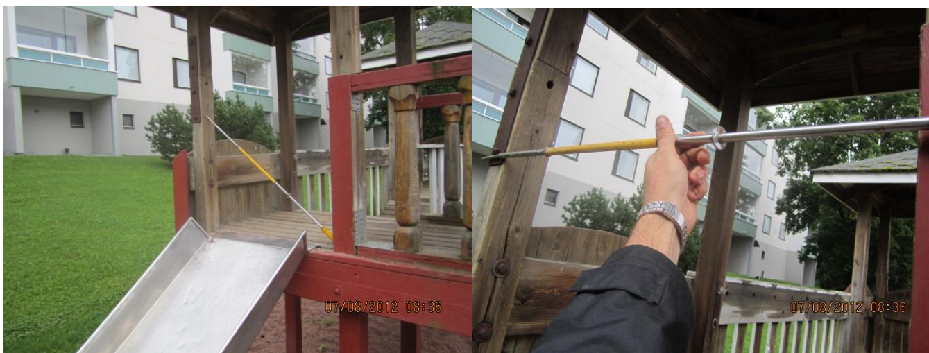
Aloitustanko puuttuu ** Asenna aloitustanko Käyttökiellossa
