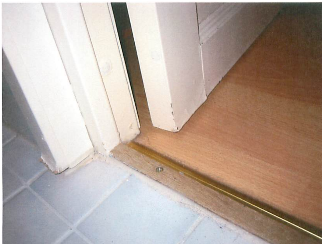
Kuva 9. Kylpyhuoneen kynnys on erittäin matala ja ovesta ja listassa kosteusvaurion jälkiä. Kynnys tulee olla vähintään 15mm valmiista lattianpinnasta.
