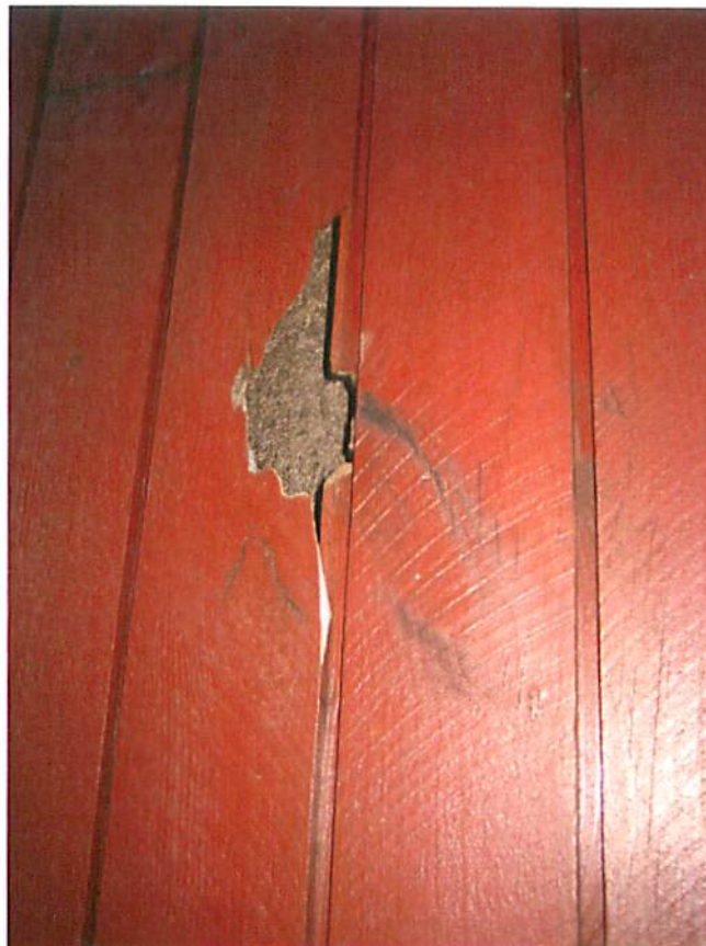
Kuva 1 Osassa taloa on julkisivupaneelit pahoin haristuneet..
