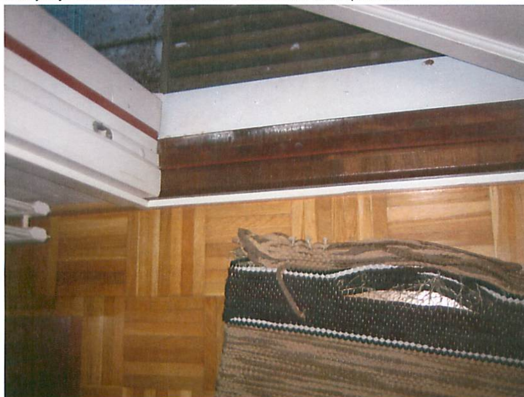
Kuva 9. Kylpyhuoneen kynnys on erittäin matala ja ovesta ja listassa kosteusvaurion jälkiä. Kynnys tulee olla vähintään 15mm valmiista lattianpinnasta.
