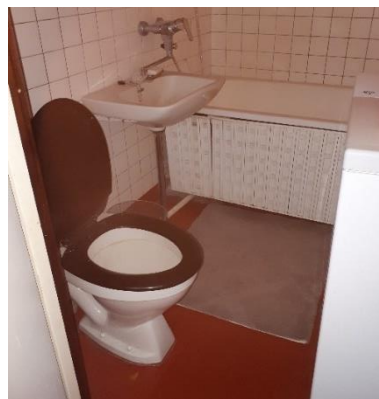
Kuva 2. Alkuperäinen 2-otehana ja kylpyhuoneen vanhoja vesi- ja viemärikalusteita
