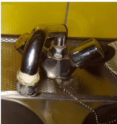
Kuva 2. Alkuperäinen 2-otehana ja kylpyhuoneen vanhoja vesi- ja viemärikalusteita
