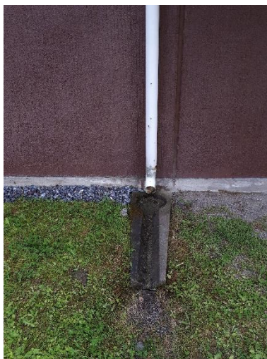
Kuva 4. Parvekkeiden kattojen sadevedet johdettu pihamaalle.
