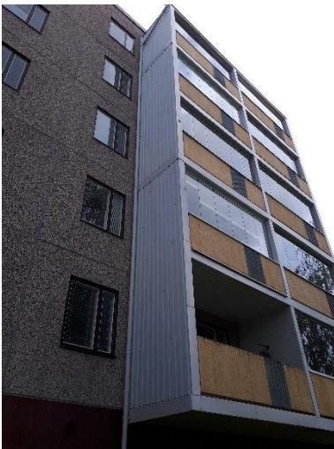
Kuva 4. Parvekkeiden kattojen sadevedet johdettu pihamaalle.
