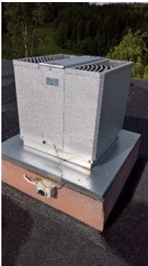
Kuva 6. Huippuimuri vesikatolla ja vesikattokuva.
