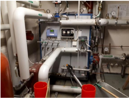
Kuva 5. Lämmönjakokeskus.
