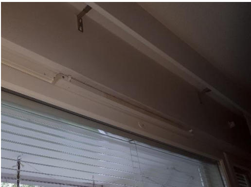
Kuva 7. Ikkunan yhteydessä oleva korvausilmaventtiili ja huoneiston poistoilmaventtiili
