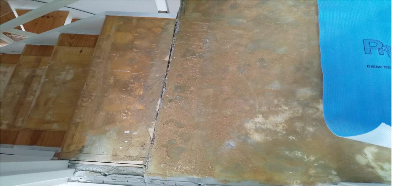
Yläkerran vanha mattoliima kelluvan parketin alla ei sisällä asbestia.
